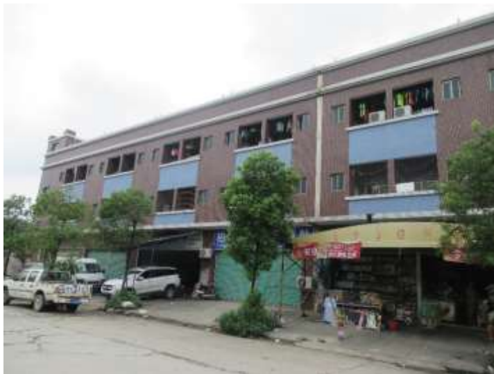
西南面园区企业员工倒班宿舍
