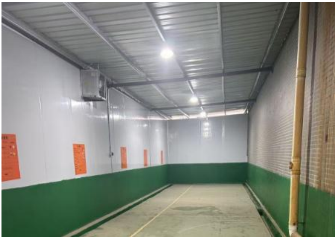
图 2-4e 项目依托危险废物暂存间（GF-010115）
