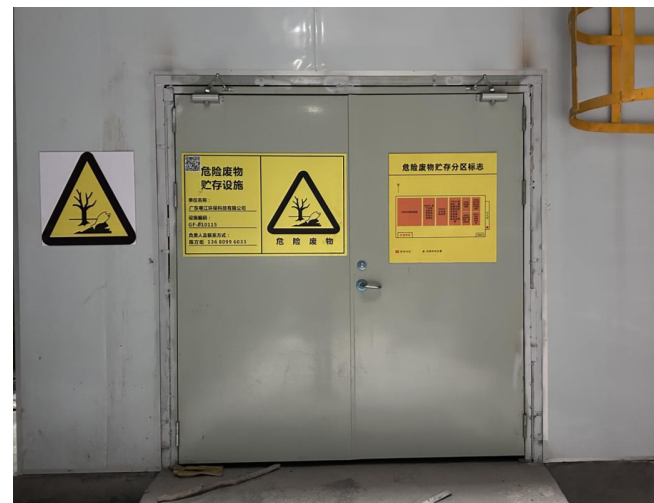
图 2-4d 项目依托危险废物暂存间 (GF-010115)
