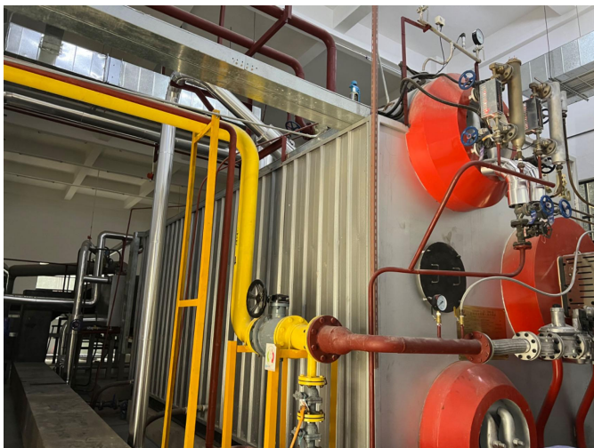
图 2-4a 10t/h 燃天然气蒸汽锅炉
