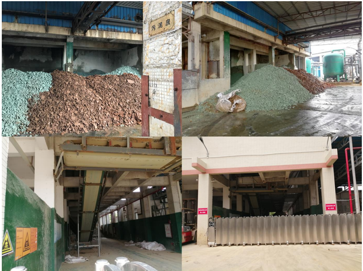
2.3-4 固体废物贮存区现状
