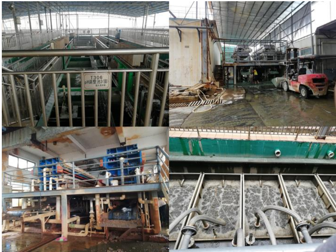
图 2.3-3 废水治理区现状
