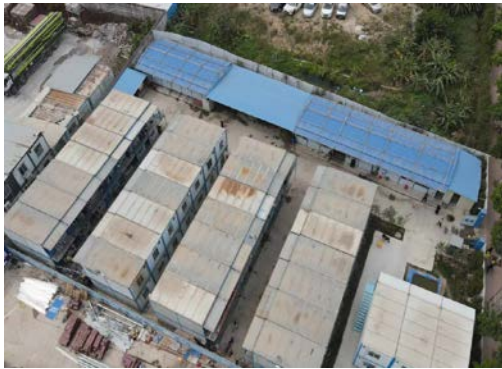
施工营造区现状
