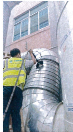
搅拌、倾倒、压料、投料、称料工序废气处理前采样口
