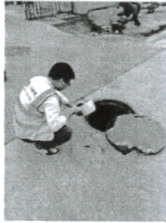
生活污水采样
