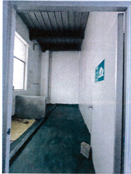
一般固废暂存处
